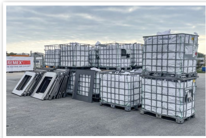
Zur Abholung bereit: die verpackten Gitterboxensysteme mit asbesthaltigen Abfällen in Zusammenarbeit mit REKS
