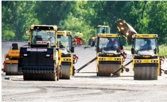
Ökologisch sicherer Einsatz im Erd- und Straßenbau
